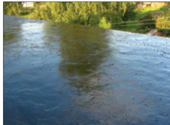
Кровля после ремонта.
